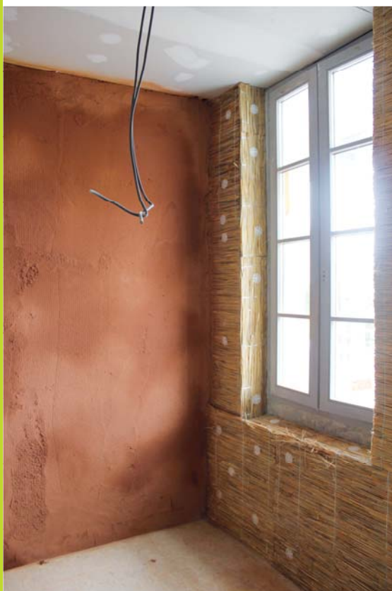
Couche d'accroche de l'enduit en terre et isolation
