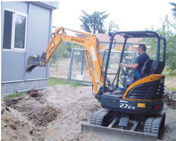
Création d'une tranchée pour la mise en place du cablage électrique et informatique
