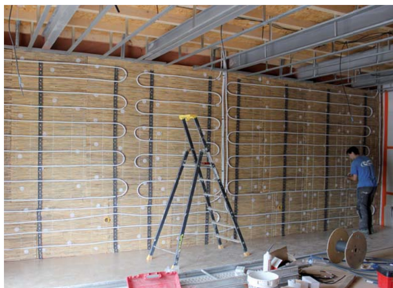
Mur chauffant sur isolation en roseaux
