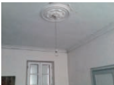
Mairie de St-Caprais avant les travaux
