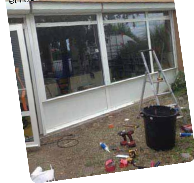
Travaux de menuiserie écoles La Bastide, Les Garrosses, Ancien Collège et Piscine Municipale
