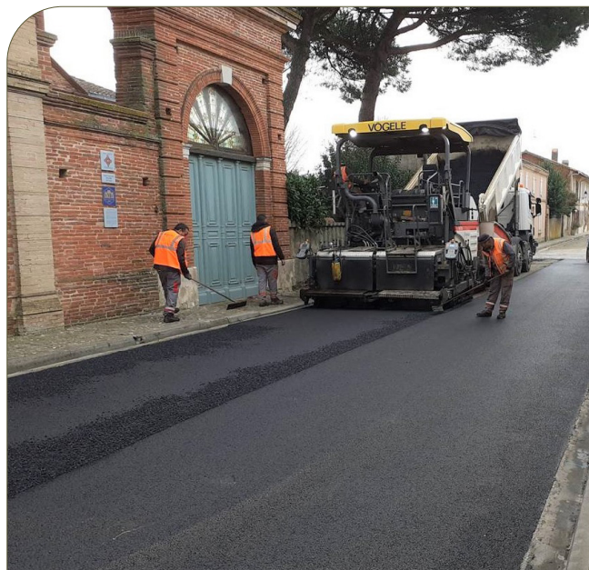
Grenade 2020 - Travaux réalisés rue Roquemaurel
